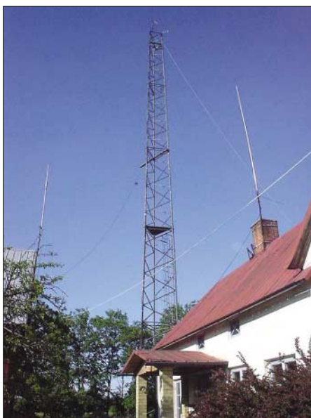
Der 30 m hohe Antennenmast von SM1LCA
